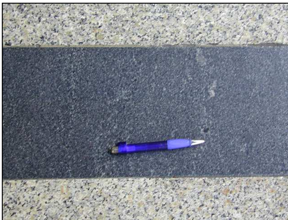
Fig. 21 – Fascia in Diorite di Anzola nella pavimentazione di Via Roma a Torino.
